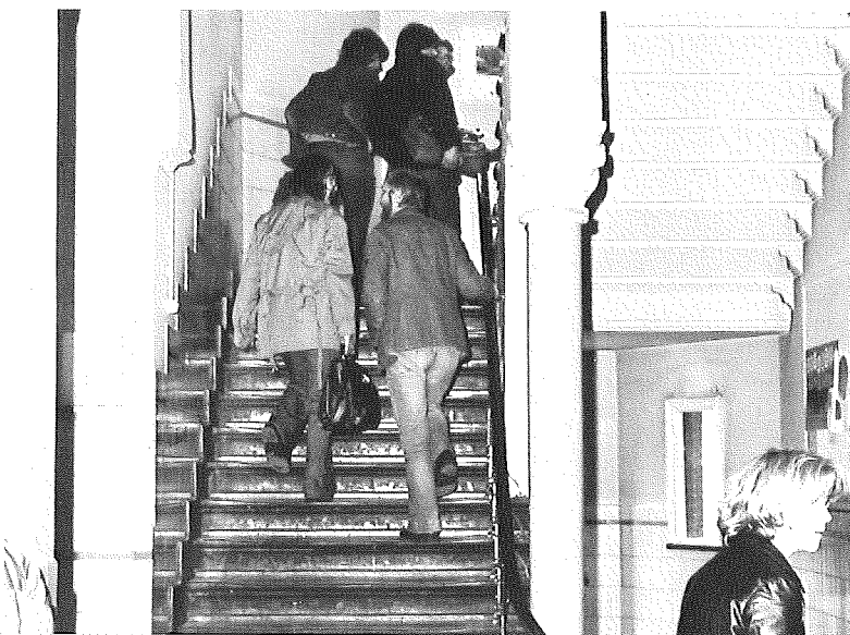
Trapportaal en trap hoofdingang gebouw Nolensplein.
