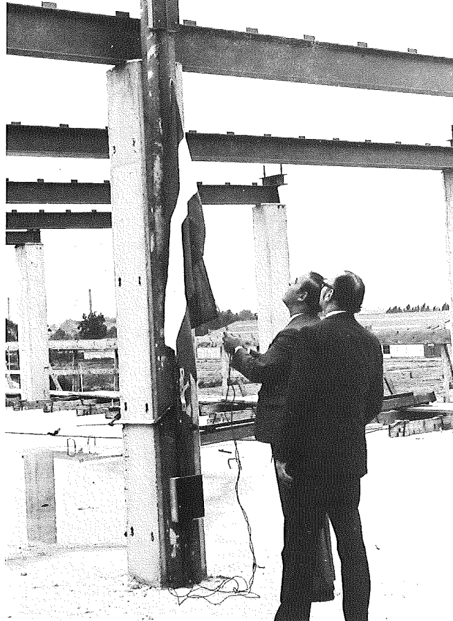
Het hoogste punt van de nieuwbouw aan de Waterboenstraat is bereikt. De vlag gaat in top. Najaar 1976.
